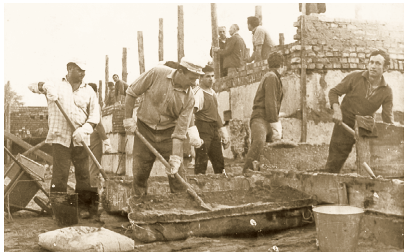
Будівництво Дому Молитви, 1989 рік
