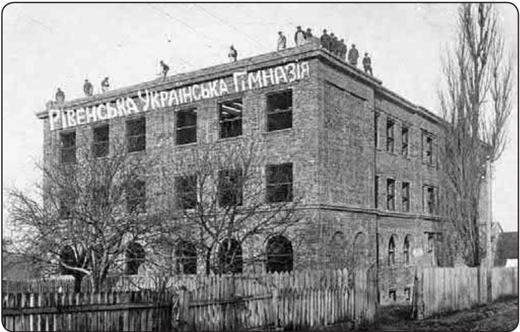
Будівництво нового приміщення для Рівненської української приватної гімназії на вулиці М.Дубецького. Фото. 30-і рр. ХХ ст.
