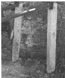
Рис. 57. Залишки древніх стін в котловані по вул. Соборній в м. Рівне (пісковик на глині)
