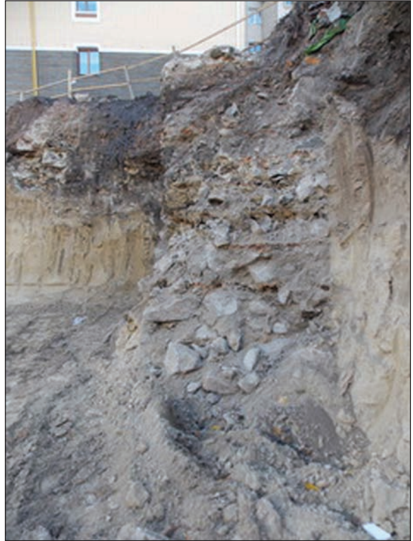
Рис. 2.20. Кам'яний фундамент у західній частині об'єкту 1, вигляд із півночі
