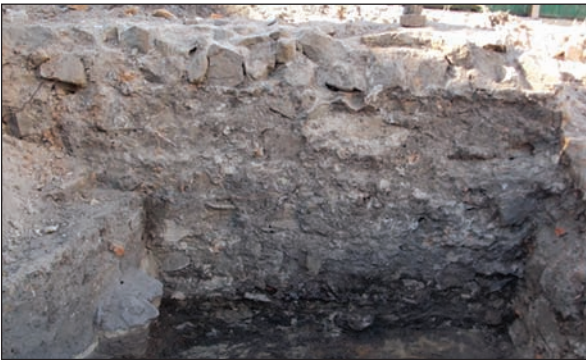
Рис. 2.18. Кам'яний фундамент у західній частині об'єкту 1, вигляд зі сходу
