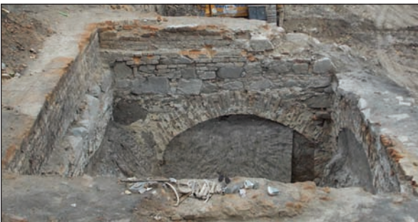
Рис. 2.39. Результати розчистки міжстінних переходів із цегляними склепіннями у межах об'єкту 2, вигляд із півдня
