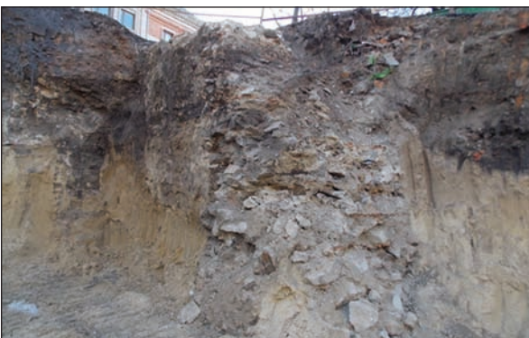
Рис. 2.19. Кам'яний фундамент у західній частині об'єкту 1, вигляд із північного сходу
