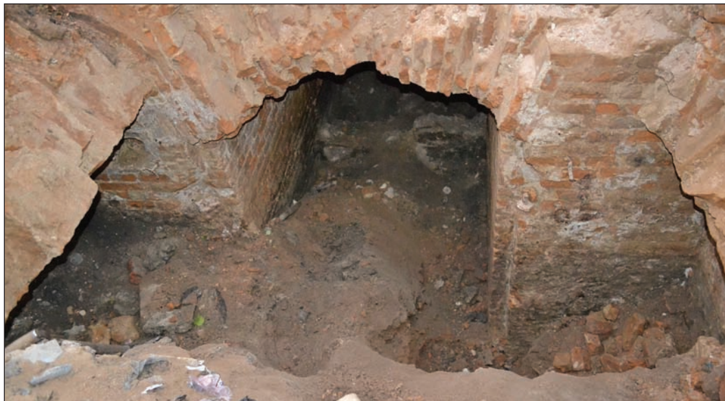
Рис. 5.22. Провал 1 на вул. Великій Бердичівській після розчистки, вид із північного заходу
