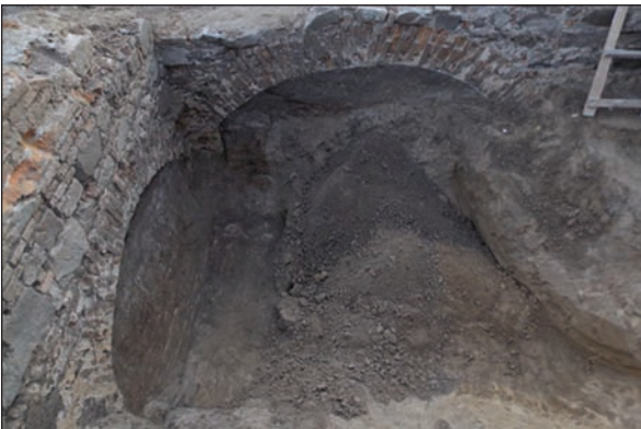
Рис. 2.38. Розчистка міжстінних переходів із цегляними склепіннями у межах об'єкту 2, вигляд із заходу
