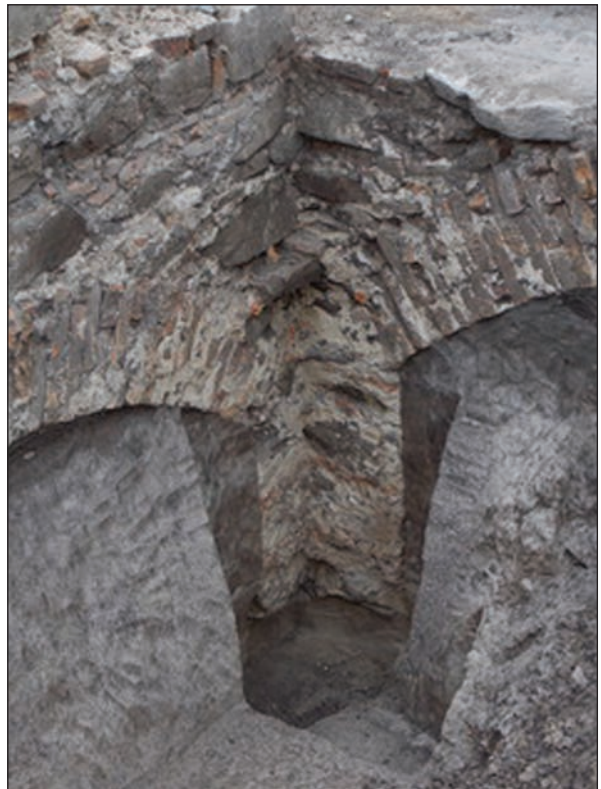
Рис. 2.41. Склепінчаста конструкція фундаменту будівлі у межах об'єкту 2, вигляд із південного заходу
